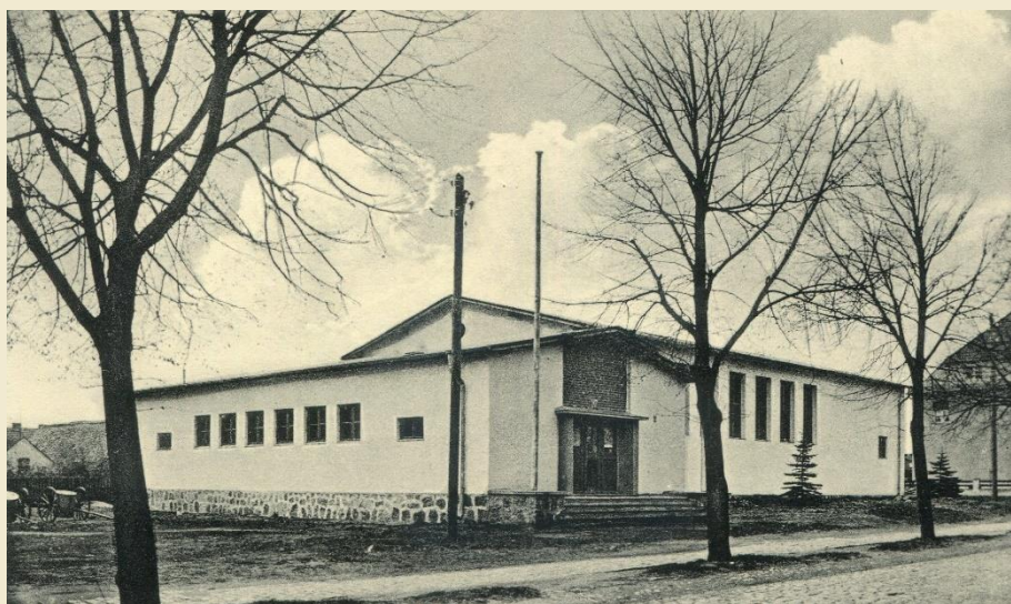
Budynek hali sportowej (uroczystości) wzniesiony w 1936 r.
