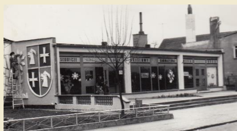
Wybudowany w 1969 r. pawilon przy ulicy Wolności
